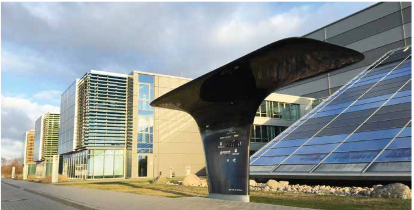
Die statisch anspruchsvolle Form der neuen CFK-Bushaltestelle im CFK-Valley Stade lässt sich mit konventionellen Baustoffen nicht realisieren
