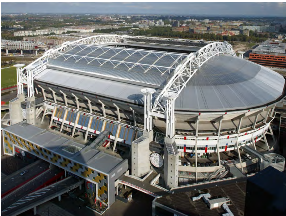
Bild 2: Dach der Amsterdam Arena, bestehend aus Lexan solar control IR® [Sabic Innovative Plastic]
